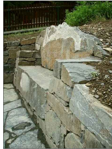
PŘÍKLADY ZAKOMPOOVÁNÍ VELKOFORMÁTOVÝCH KAMENŮ A VYTVOŘENÍ SEZENÍ
